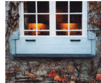
Hochwasserschutz an Fensteröffnungen
